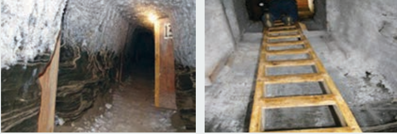
Images d'une installation souterraine d'entreposage d'aliments de Tuktoyaktuk, dans les T. N.-O. Ces installations sont à risque, en raison de la fonte du pergélisol.
